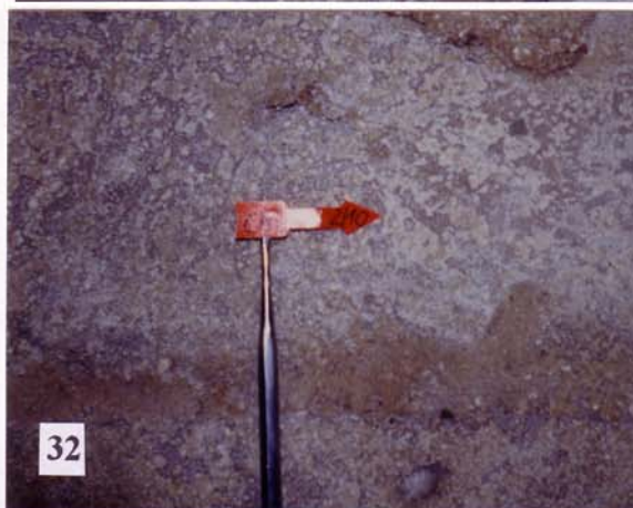
Abb.28: Probenahmestelle CH 2/7: Salzausblühung im Keller unter dem westlichen Kreuzgang ( \text{KNO}_3 )
