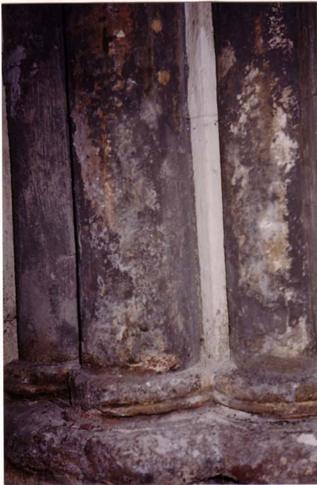
Abb.27: Na-Sulfat-Salz am Probenpunkt 10
