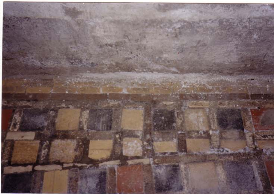
Abb.28: Na-Sulfat-Salz und Gips am Probenpunkt 11
