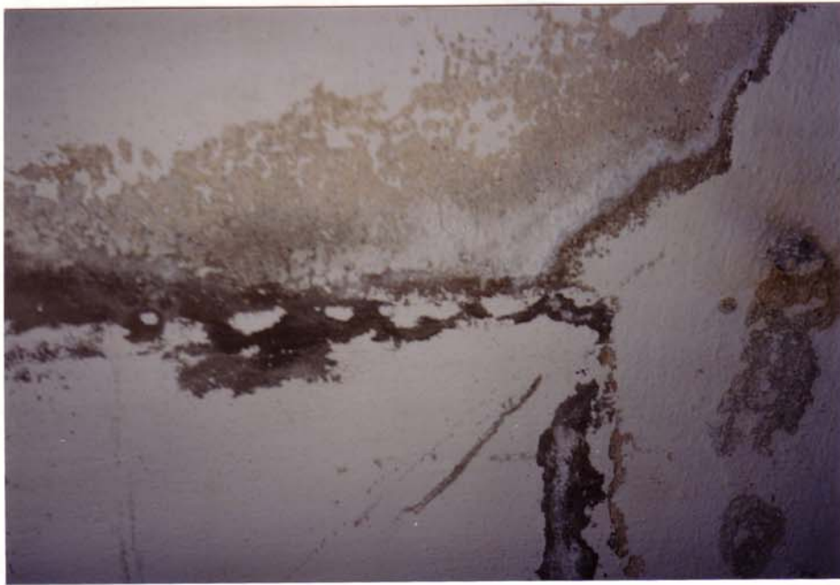
Abb.26: Na-Sulfat-Salz am Probenpunkt 8
