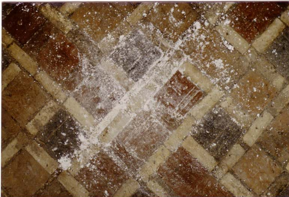
Abb.24: Gips am Probenpunkt 6
